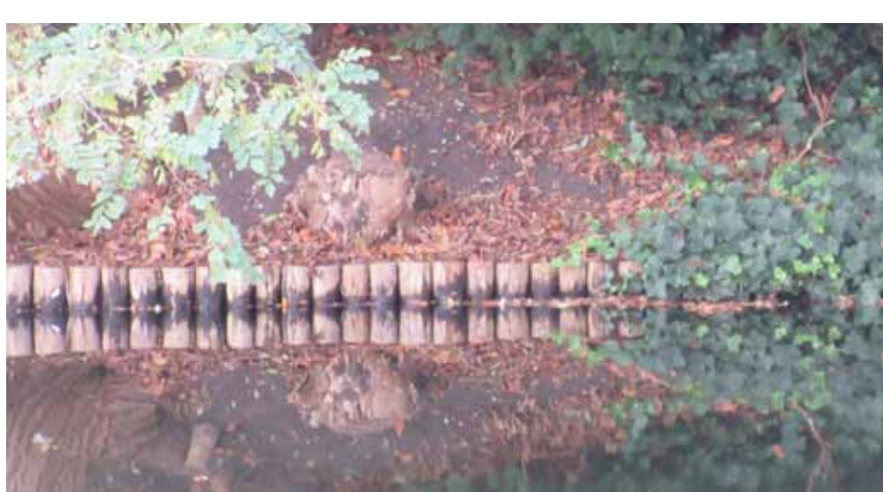
Nabij bruggen een perkoenpalenbeschoeiing.
